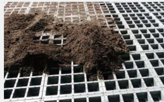
Für die Begrünung wird das TTE ® MultiDrain PLUS mit einem lockeren Gemisch aus Oberboden, Sand und Feinkies verfüllt.
