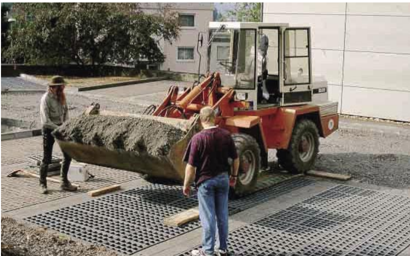
Fugenverfüllung nach dem Verlegen auf 2-3 cm Ausgleichsschicht.
