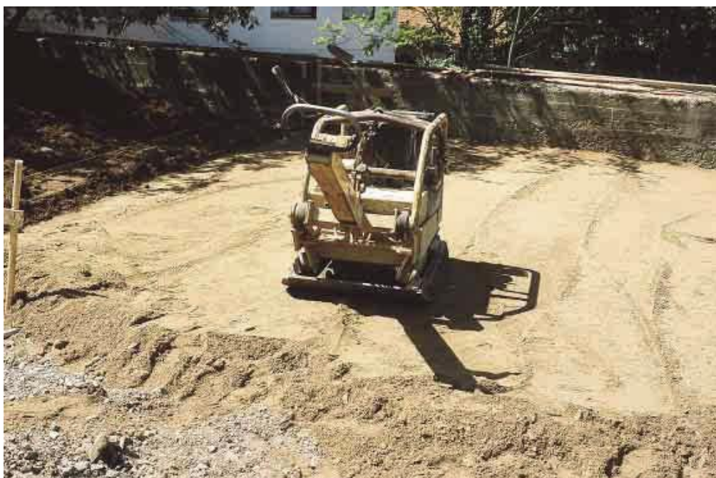
Einbau eines nicht bindigen Untergrundmaterials auf der Versuchsfläche.
