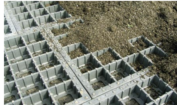
Für die Begrünung wird das TTE ® -Gitter mit einem lockeren Gemisch aus Humus und Rundkies 2-4 mm verfüllt.
