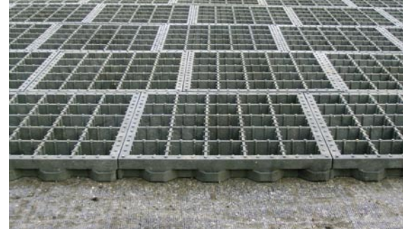
Ein Verlegenetz aus feinmaschigem Kunststoff erleichtert das schnelle Verlegen von grossen Flächen. Die seitenversetzte Anordnung um 1 Kammer erhöht die horizontale Stabilität.
